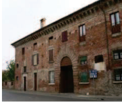
Edificio storico in mattoni pieni
