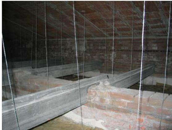
Solaio sostituito con controsoffitto
