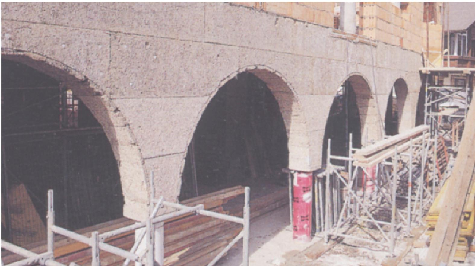
Ponte termico isolato con pannelli Celenit N spessore 35 mm.
